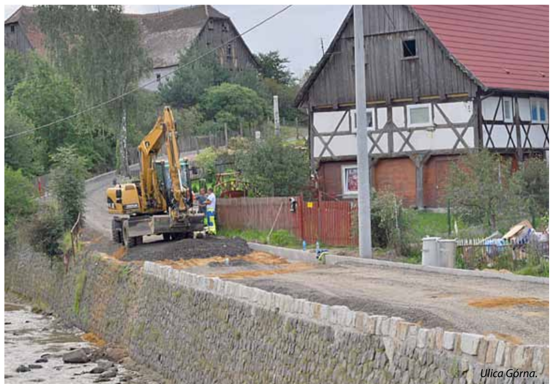
Budowa bloków przy ul. M.C. Skłodowskiej.
