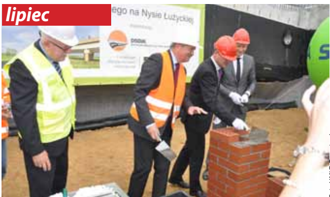
lipiec Wbudowanie kamienia węgielnego pod budowę mostu granicznego na Nysie Łużyckiej.
